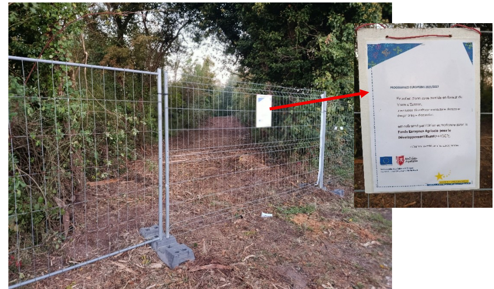
Figure 11 : barrière de sécurité au niveau du chemin d'accès, avec affiche plastifiée du projet - octobre 2025
