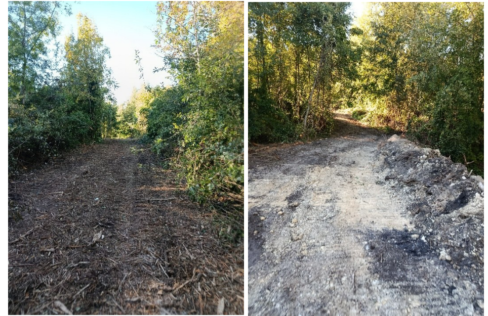
Figure 9 : après intervention - chemin d'accès et rampe aménagée - octobre 2025
